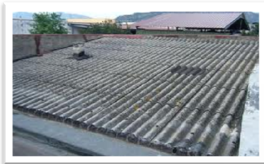
Tetto in cementoamianto.
