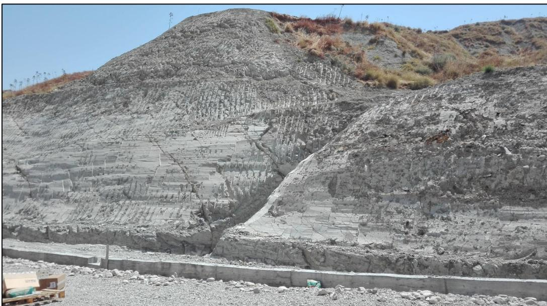
Le argille sono interessate, spesso, da fratture estensionali e da bande giallastre di alterazione, quale risultato di azione di stress di epoca pre-pleistocenica.
