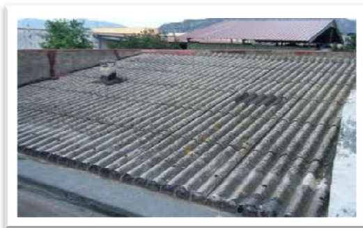
Tetto in cementoamianto.
