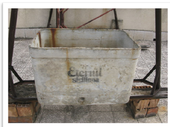
Serbatoio per l'acqua in eternit.
