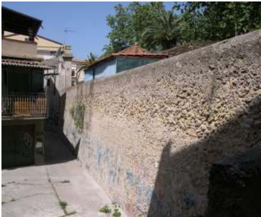
FOTO 5.1 – Cortina muraria tra Bastione Villafranca e Bastione Orsini
