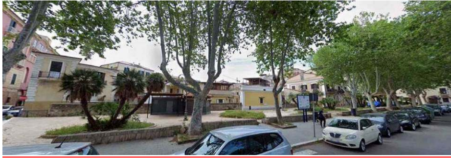
FOTO 5.2 – Cortina muraria tra Bastione Villafranca e Bastione Orsini
