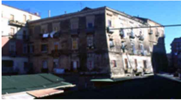
FOTO 3.1 – Bastione Toledo faccia e fianco
